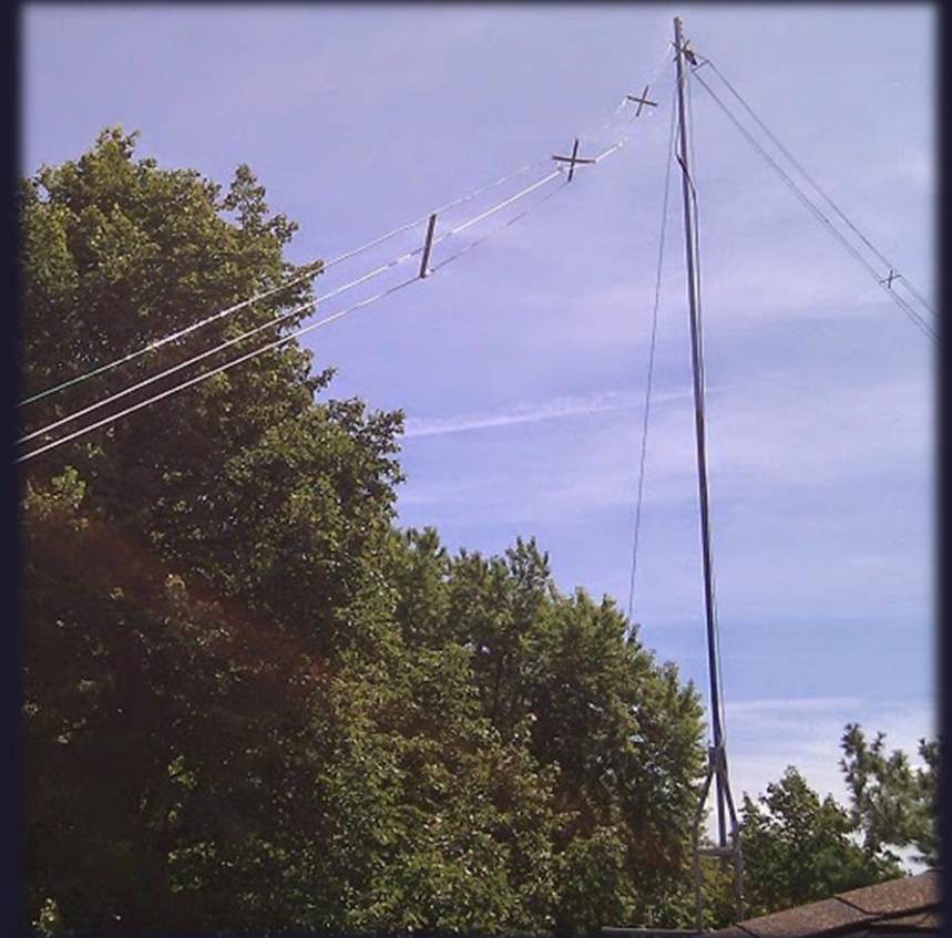
Multi-Band Inverted-V Fan
